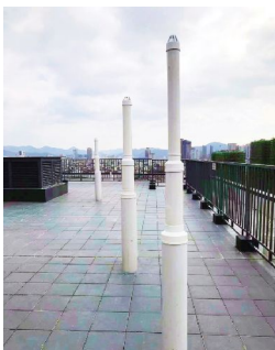
(改良后屋面排气管)
