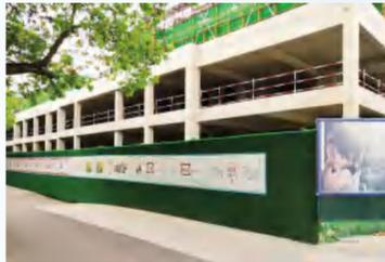
这些“绿墙”其实是用仿真草皮制作的仿绿植围挡，每块围挡均由不同颜色的仿真植物构成，整体实现了立体绿化。据介绍，相比之前的广告布，绿色草皮的植绒能吸附灰尘，减少扬尘，隔音降噪效果佳，能进一步减少施工对周边的影响。“绿墙”背面实际是有框架支撑的金属板，这种钢结构围挡占地面积小、施工速度快，也更加环保，在施工工程结束之后，还能将它拆除清洗、循环利用。
